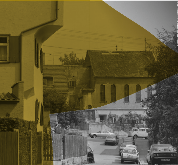
DIE EHEMALIGE SYNAGOGE KRIEGSHABER VOR DER SANIERUNG
